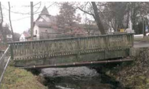
Leider mussten die beiden Brücken über die Würm an der Allacher Straße / Wehrstaudenstraße sowie am Eichenweg gesperrt werden. Die erforderliche Bauwerksüberwachung durch die Mitarbeiter der Gemeinde Karlsfeld ergab, dass die Brücken nicht mehr verkehrssicher sind. Eine Sanierung war auch aufgrund der maroden Holzkonstruktion nicht mehr möglich.
