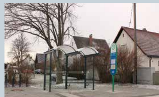
Die Bushaltestelle Parkstraße wurde in Zusammenarbeit mit einer Straßenbaufirma saniert.
